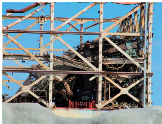
水素爆発後の1号機建屋上部の瓦礫。2021年10月18日現在。
